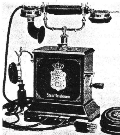
Figur 2.15. Billede af en telefon fra den tid, hvor centralerne var manuelt betjente. Det karakteristiske håndsving skulle bruges til at ringe op og ringe af, når man skulle starte og slutte en samtale.
